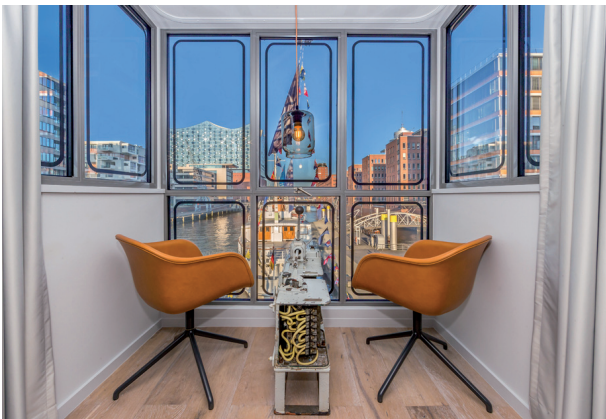
pic_04_Hafenkran.jpg: Die reflektierenden Sonnenschutzverglasung gestattet den Ausblick und verwehrt den Einblick; so ist die Privatsphäre der Gäste bestmöglich geschützt. Das aufgeklebte, schwarze Profil „rundet“ den Ausblick ab.
