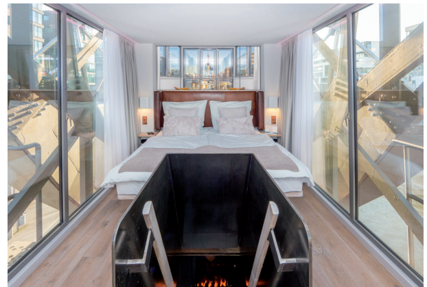
pic_05_Hafenkran.jpg: Das Schlafzimmer in der ehemaligen Kranführerkanzel ist nahezu rundum verglast. Die grossen Scheiben wurden mit einem Kran durch das offene Dach gehievt, da die äusseren Verstreben das seitliche Einbringen verhinderten.
