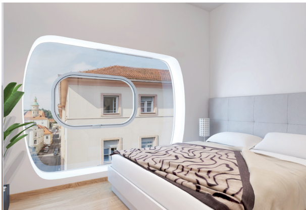
vis_06_Argos_Top_2_SZ_03.jpg: Die Fensterelemente mit den öffnbaren Klappflügeln aus Janisol Arte 2.0 wurden in einen millimetergenauen Ausschnitt der raumabschliessenden Verglasung eingepasst und mit Glasleisten fixiert.
