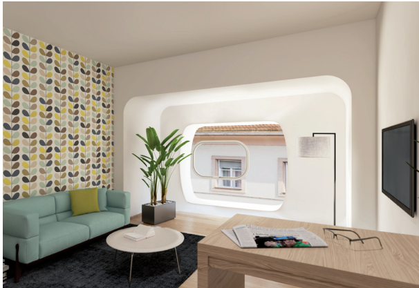
vis_04_Argos_Top_3_WZ_03.jpg: Die Aussenhülle der „Bubbles“ ist aus glasfaserverstärktem Kunststoff (GFK) gefertigt und wurde auf eine Unterkonstruktion aus Brettschichtholz aufgesetzt; die innenliegende Verkleidung wird mit Gipsplatten ausgebildet.
