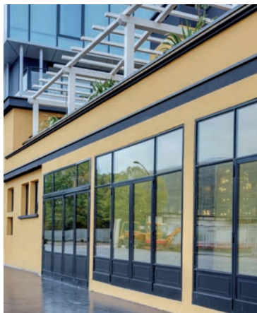
pic_12_molitor: Fenstertüren und Festverglasungen aus dem Stahlprofilssystem Janisol an der Südfassade; darüber die rekonstruierte Pergola.
