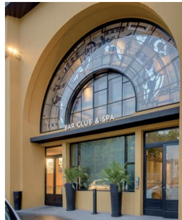
pic_13_molitor: Türen aus dem Stahlprofilssystem Janisol im Eingangsbereich des „Bar, Club & Spa“; darüber die originale Tiffany-Verglasung.
