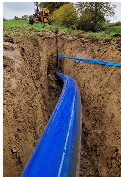
Als Rohrleitungssystem kam das bewährte Wavin TS von Jansen mit einer Dimension von 160 x 14.6 S5 PN16 und einer Gesamtlänge von 672 Meter zum Einsatz. Jansen Wavin TS DOQ® besteht aus hochbelastbarem, spannungsrisssbeständigem Finathen N 8000 der Werkstoffgruppe PE 100 RC.
