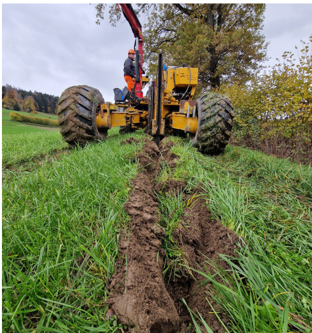
Rechts: Bei den Installationsarbeiten kam mittels Einpflügen der Kabelpflug KPZ 160 mit der 30 Tonnen Seilwinde der Firma Zemp Leitungs- und Tiefbau GmbH zum Einsatz.
