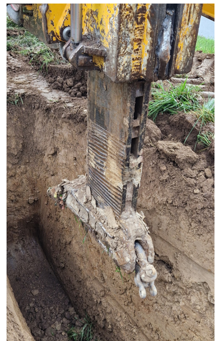
Rechts: Bei den Installationsarbeiten kam mittels Einpflügen der Kabelpflug KPZ 160 mit der 30 Tonnen Seilwinde der Firma Zemp Leitungs- und Tiefbau GmbH zum Einsatz.
