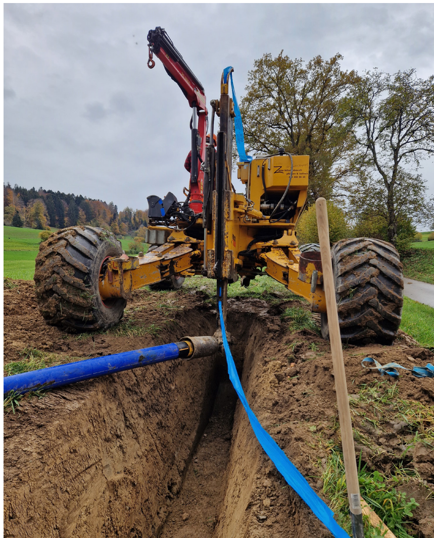
Mit dem Spezialfahrzeug, einer 30-Tonnen-Winde, welche über eine gewaltige Leistungsstärke verfügt, sind selbst Steigungen über 100 %, Waldpartien, Böschungen und Bäche keine Hindernisse. Das Kabelpflügen eignet sich besonders im Bereich Strom, Telekommunikation, Wasser, Abwasser, Gülle und Gas.
