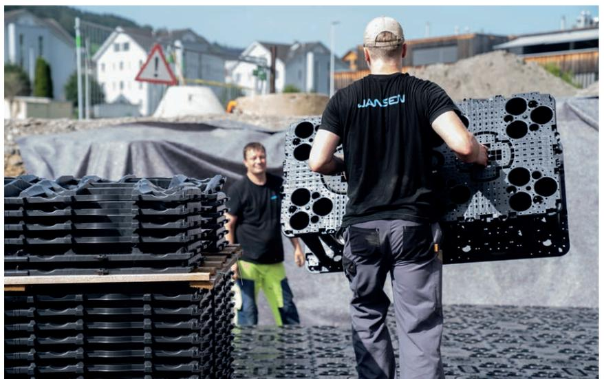
*Leicht und stark belastbar: Mit nur 11.4 kg pro Element verringert AquaCell dank einfachen Steckverbindungen die Bauzeit.*
