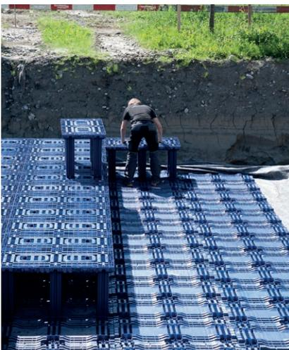
Die Anlage der «Kanti Heerbrugg» ist mit dem beachtlichen **Speichervolumen von 141 m<sup>3</sup>** eine der grösseren im Rheintal. Hergestellt aus 100% Polypropylen (PP) Neumaterial bietet das System hervorragende und konstante Materialeigenschaften, wodurch eine hohe Lebensdauer erreicht werden kann.
