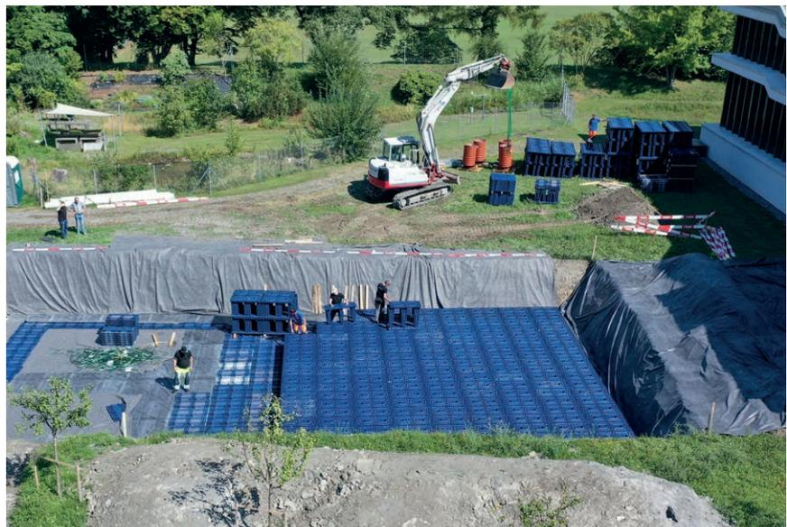
Die Q-Bic Plus Regenwasserbewirtschaftung umfasst das Sammeln, Transportieren, Vorbehandeln, Drosseln und Versickern bzw. Rückhalten von Regenwasser. Sie überzeugt durch das geringe Gewicht und die schnelle Installationsgeschwindigkeit.
