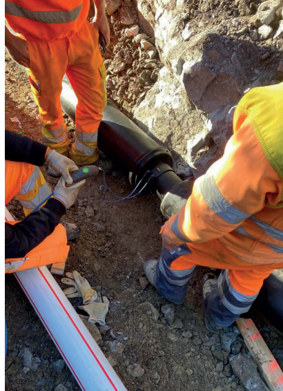
Druckprüfung der fertig geschweissten Rohre.
