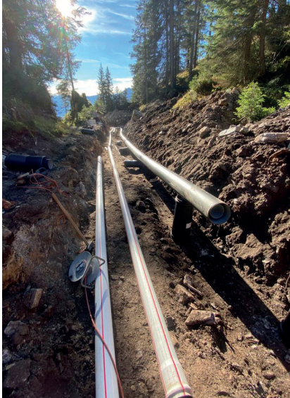
800 Meter Doppelwand Leitungen JANSEN bianco werden verbaut.
