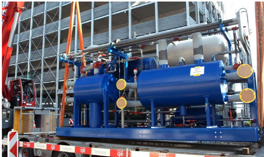
Le pompe di calore di grandi dimensioni del produttore svizzero Walter Wettstein AG forniscono complessivamente circa 5,5 MW di calore e freddo. Le macchine sono lunghe sei metri e pesano 15 tonnellate ciascuna. Funzionano con il refrigerante naturale NH3 (ammoniaca). Il fabbisogno energetico per il dimensionamento del campo geotermico è stato stimato in circa 5-6 GWh all'anno.
