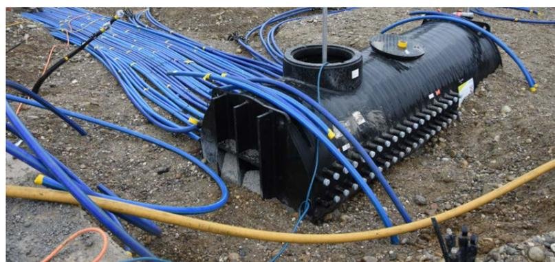
Neuf puits de distribution enterrés de type JANSEN u-boot ont été utilisés. Les chambres de distribution cylindriques et horizontales en forme de «sous-marin» offrent suffisamment de place pour les grandes dimensions de distributeur, les installations spéciales et jusqu'à 80 circuits de saumure.
