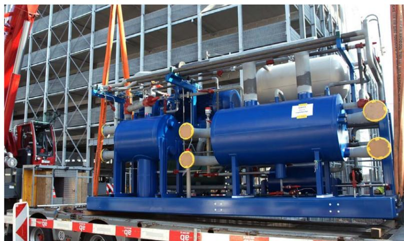
Les grandes pompes à chaleur du fabricant suisse Walter Wettstein AG fournissent une puissance totale d'environ 5,5 MW en chaleur ainsi qu'en froid. Les machines mesurent chacune six mètres de long et pèsent 15 tonnes. Elles fonctionnent avec le réfrigérant naturel NH3 (ammoniac). Les besoins en énergie ont été estimés à environ 5 à 6 GWh par an pour la conception du champ de sondes.
