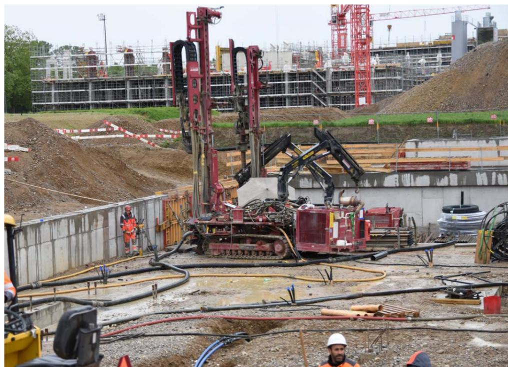
270 forages de sondes géothermiques de 290 mètres chacun ont été réalisés par les professionnels de Barmettler Erdenergie. La géologie plutôt molle a permis d'atteindre une vitesse de forage très élevée d'environ 40 mètres par heure.
