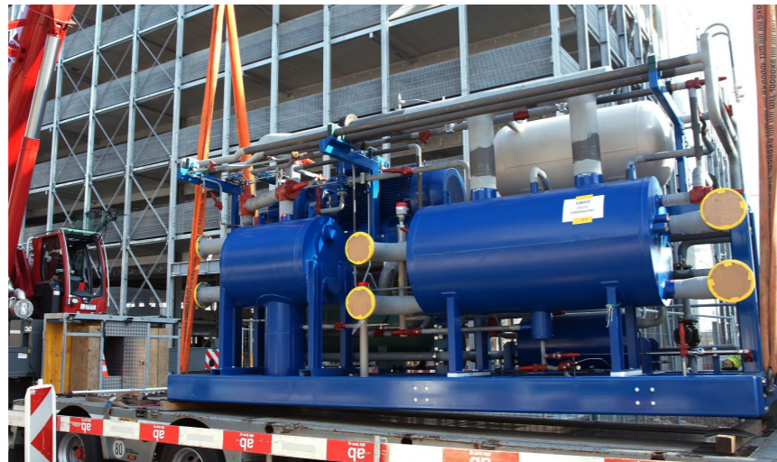
Die Grosswärmepumpen des Schweizer Herstellers Walter Wettstein AG stellen insgesamt rund 5.5 MW Leistung an Wärme sowie Kälte bereit. Die Maschinen sind jeweils sechs Meter lang und 15 Tonnen schwer. Sie werden mit dem natürlichen Kältemittel NH3 (Ammoniak) betrieben. Der Energiebedarf wurde zur Auslegung des Sondenfeldes auf ca. 5 bis 6 GWh pro Jahr geschätzt.
