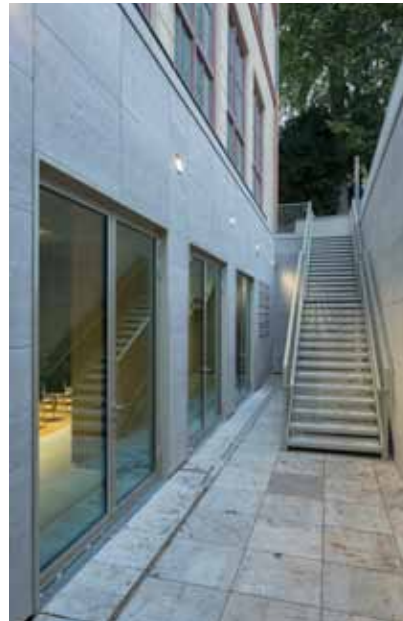
pic_06: In den Tiefhöfen des UG gewährleisten raumhohe Fenstertüren und Festverglasungen aus dem schmalen Stahlprofilsystem Janisol maximalen Tageslichteinfall.
