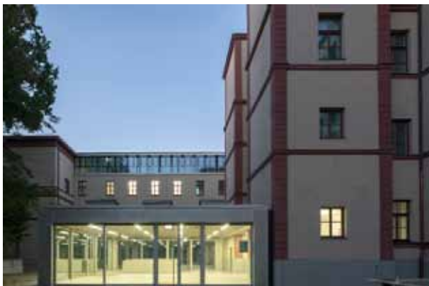
pic_04: Das zusätzliche Geschoss wurde unter Beibehaltung der Traufhöhe zur Maximilianstraße unter einem neuen Pultdach integriert. Es beherbergt weitere Klassen- und Werkräume.
