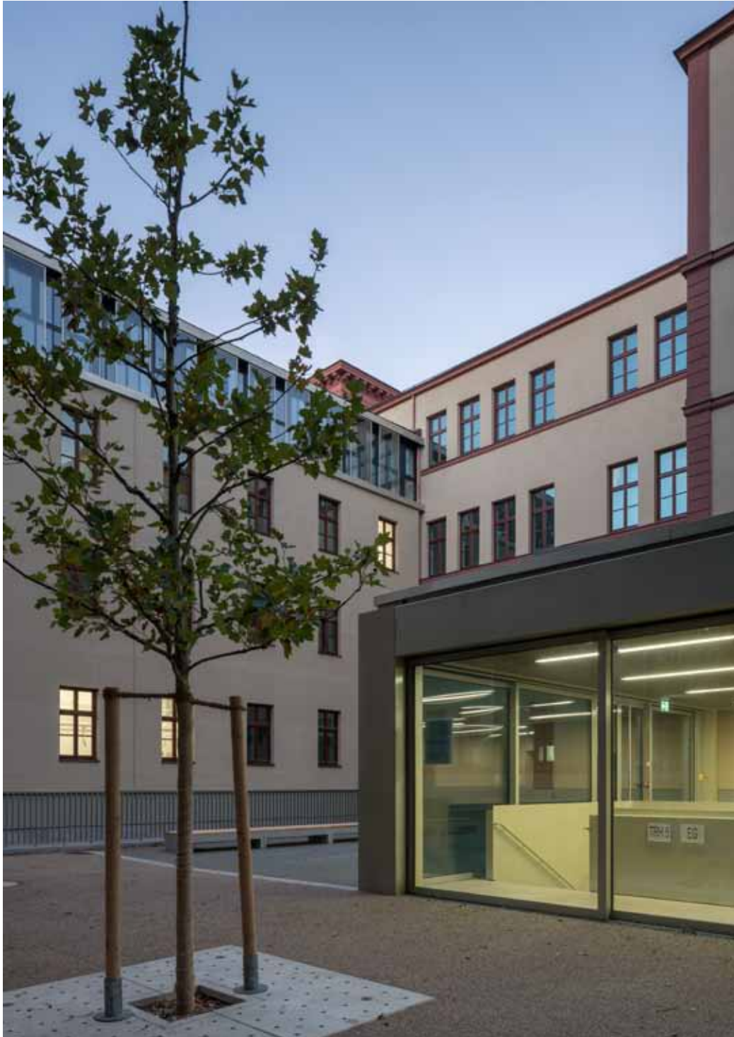
pic_01: Mit einer transparenten Pausenhalle, einem zusätzlichen Dachgeschoss und einer unter dem Pausenhof angeordneten Einfachsporthalle haben BPA Braun Architekten, München, das Wilhelmsgymnasium um rund 1600 Quadratmeter zusätzliche Fläche erweitert, ohne dass sich zur denkmalgeschützten Maximilianstraße hin davon etwas abzeichnet.
