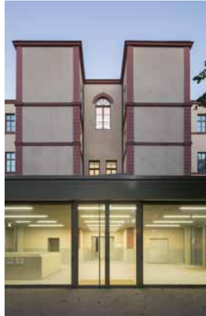
pic_05: Zusätzlich zu den verglasten Drehtüren erhielt die Pausenhalle 260 x 280 cm grosse Hebeschiebetüren, die im Sommer geöffnet werden können.
