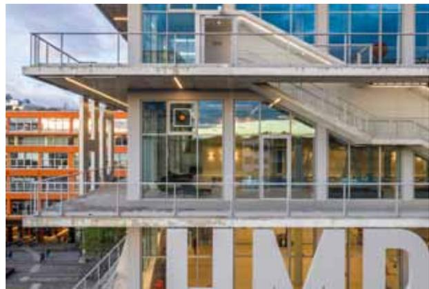
pic\_05\_110\_Werk12\_©Ossip.jpg: In Bereichen, vor denen die Kaskadentreppe verläuft, werden die Lasten der Verglasung über den Querriegel seitlich in die Betonkonstruktion abgetragen.
