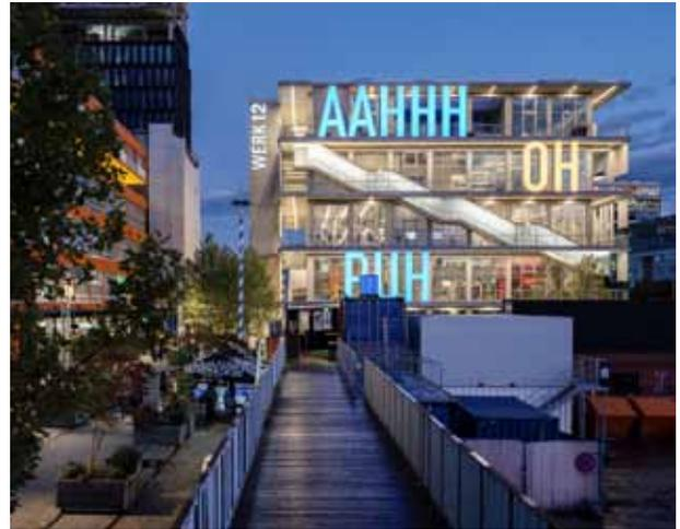
pic\_03\_047\_Werk12\_©Ossip\_1.jpg: Realisiert wurde sie als VISS Fassade in einer Ansichtsbreite von 50 mm und zwei unterschiedlichen Bautiefen.
