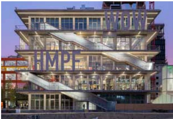
pic\_04\_016\_Werk12\_©Ossip.jpg: In einem umlaufendem Rahmen von 120 mm Tiefe sitzen zwei Pfosten und, auf der Höhe von 3 m, ein Riegel, die nur 95 mm tief sind.
