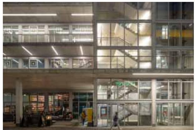
pic\_07\_101\_Werk12\_©Ossip.jpg: Die Janisol 2 F30-Brandschutzverglasung im (kalten) Treppenhaus wurde mit ZIE realisiert, da der Einbau vor Inkrafttreten der DIN EN 16034 zum 1.11. 2019 erfolgte.
