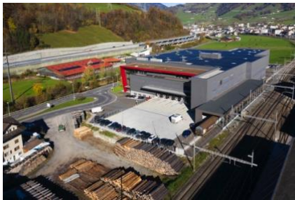
Bild 6: Bei der in Seewen verwendeten Variante des Fenstersystems AWS (Aluminium Window System) sorgen automatisierte Kippflügel für eine selektive Nachtauskühlung und ebenfalls automatisierte RWA-Drehflügel gewähren im Notfall die Entrauchung.
