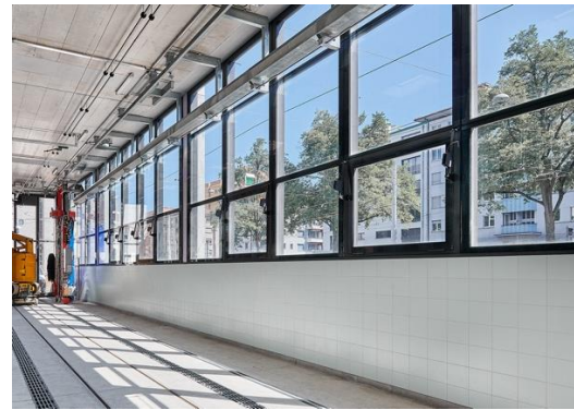
Bilder 7 bis 10 – Da die bestehende, offene Aussenwaschanlage die betrieblichen Anforderungen nicht mehr erfüllte, wurde eine eingehauste Waschanlage gebaut. Hier kommt das Aluminium-Fenstersystem Schüco AWS 65 zur Anwendung. Mit der Einhausung können alle heutigen und zukünftigen Tramfahrzeuge vollständig und witterungsunabhängig gereinigt werden. Gleichzeitig wird die Lärmemission zum Wohnquartier reduziert.
