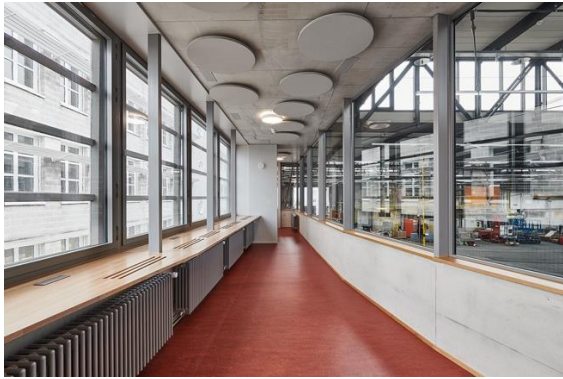
Bilder 5 und 6 – Vor der energetischen Sanierung war die Gebäudehülle der Halle ungedämmt und sorgte für starke Temperaturschwankungen im Innern. Die denkmalgeschützten originalen Fenster im Dienstgebäude wurden mit Janisol HI Vorsatzfenstern ergänzt bzw. zur Halle mit Janisol HI Fenster aus Stahl gedämmt. In den Janisol HI Fenstern verbinden sich filigrane Rahmenprofile mit der innovativen Technologie für höchste thermische Trennung inkl. Dreifachisolierglas.
