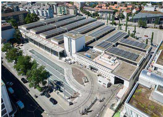
**Bild 1** – 2020 bis 2022 wurde das denkmalgeschützte Tramdepot in Zürich Oerlikon (1932–35) vom damaligen Stadtbaumeister Hermann Herter energetisch ertüchtigt und betrieblich optimiert. Für die Dämmung der Halle kamen Janisol HI Vorsatzfenstern und Janisol HI Fenster aus Stahl zur Anwendung.
