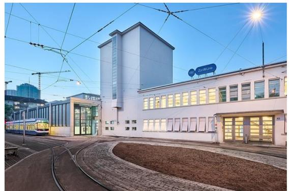
**Bild 4** – 2020–22 wurde das denkmalgeschützte Tramdepot in Zürich Oerlikon (1932–35) vom damaligen Stadtbaumeister Hermann Herter energetisch ertüchtigt und betrieblich optimiert. Für die Dämmung von Halle kamen Janisol HI Fenster aus Stahl mit Dreifachisoliertglas zur Anwendung. Beim Dienstgebäude (Gebäudeflügel rechts) wurden die originalen Bauteile wiederverwendet und mit Janisol HI Vorsatzfenstern ergänzt.
