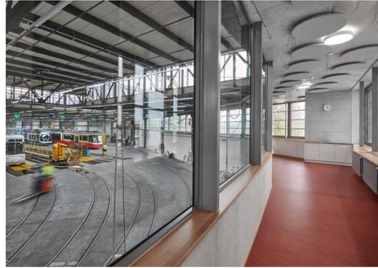
**Bilder 5 und 6** – Vor der energetischen Sanierung war die Gebäudehülle der Halle ungedämmt und sorgte für starke Temperaturschwankungen im Innern. Die denkmalgeschützten originalen Fenster im Dienstgebäude wurden mit Janisol HI Vorsatzfenstern ergänzt bzw. zur Halle mit Janisol HI Fenster aus Stahl gedämmt. In den Janisol HI Fenstern verbinden sich filigrane Rahmenprofile mit der innovativen Technologie für höchste thermische Trennung inkl. Dreifachisolierglas.
