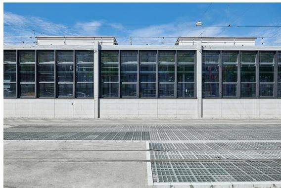
**Bild 2** – Die ursprüngliche Aussenwaschanlage wurde neu eingehaust. Die Glasfassade mit dem Aluminium-Fenstersystem Schüco AWS 65 nimmt die rhythmische Gliederung der Oberlichter der Halle auf. Mit der Einhausung können neu alle heutigen und zukünftigen Tramfahrzeuge unabhängig vom Aussenklima gereinigt werden.
