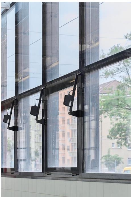
**Bilder 7 bis 10** – Da die bestehende, offene Aussenwaschanlage die betrieblichen Anforderungen nicht mehr erfüllte, wurde eine eingehauste Waschanlage gebaut. Hier kommt das Aluminium-Fenstersystem Schüco AWS 65 zur Anwendung. Mit der Einhausung können alle heutigen und zukünftigen Tramfahrzeuge vollständig und witterungsunabhängig gereinigt werden. Gleichzeitig wird die Lärmemission zum Wohnquartier reduziert.
