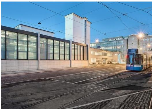
**Bild 3** – Die ursprüngliche Aussenwaschanlage wurde neu eingehaust. Die Glasfassade mit dem Aluminium-Fenstersystem Schüco AWS 65 nimmt die rhythmische Gliederung der Oberlichter der Halle auf. Mit der Einhausung können neu alle heutigen und zukünftigen Tramfahrzeuge unabhängig vom Aussenklima gereinigt
