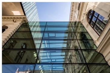
**Bild 2a und 2b:** Ein transparentes Atrium aus dem Stahlprofilssystem Jansen VISS Fassade verbindet Bibliothek und Hauptgebäude der Universität neu zu einer Einheit.
