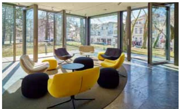
pic\_05: Insgesamt acht raumhohe, zweiflügelige Wendetüren mit versetztem Drehlager kennzeichnen diese ganze besondere Fassadenkonstruktion.
