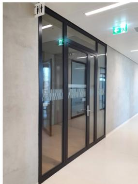
**Bild 1 und 2:** Vom EG bis zum 4. OG wurde bei Werkstätten und weiteren kleinen Raumeinheiten zahlreich auf das System Economy 60 E30 gesetzt.
