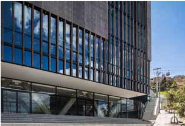
pic\_04: Erdgeschoss: Fassade im Stahlsystem Economy 50 (Türen und Festverglasung); Türen mit Panikverriegelung. Oben: Vorhangsfassade VISS Basic (mit integrierten Fenstern Economy 50). Die Stahlkonstruktion trägt das Sonnenschutzsystem aus Betonlamellen.
