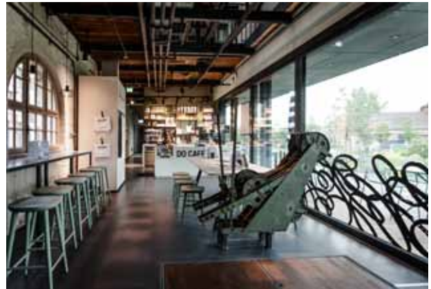
pic_05 Stellwerk 08 © shakabra: Eine fast zwölf Meter breite Hebe-Schiebetüranlage aus dem Aluminiumsystem ASS70HI des Systemhauses Schüco verbindet den Innenraum mit der aussen hinzugefügten Sonnenterrasse.
