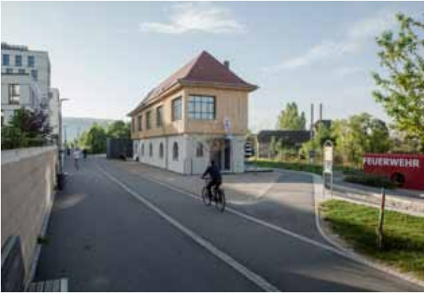
pic_02 Stellwerk 08 © shakabra: Im vergangenen Jahr hat das Stellwerk 08 eine im wahrsten Sinne des Wortes „richtungsweisende“ Umnutzung erfahren: Wo früher die Weichen für den Güterverkehr gestellt wurden, bereichert heute ein Bistro die Bahnstadt.
