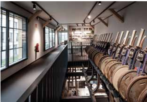
pic_06 Stellwerk 08 © shakabra: Die historischen Industrieglasungen im Obergeschoss wurden restauriert und mit Vorsatzfenstern aus dem thermisch getrennten Profilsystem Janisol Arte 2.0 von Schüco Stahlssysteme Jansen wärmetechnisch ertüchtigt.
