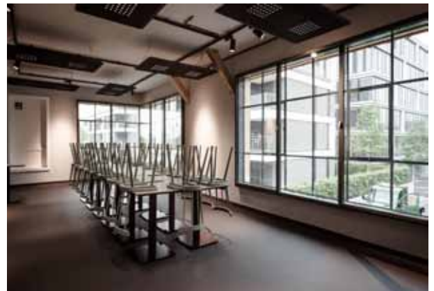
pic_07 Stellwerk 08 © shakabra: Die Öffnungsflügel der neuen Fenster aus dem Stahlprofilsysteme Janisol Arte 2.0 sind so angeordnet, dass auch die Öffnungsflügel der historischen Fenster weiterhin bedient werden können.
