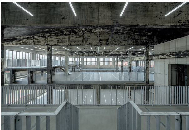
pic_06 Die zuvor mit Profilglas geschlossenen Öffnungen an Süd- und Westfassade wurden im Rahmen der Sanierung durch neue, nach historischem Vorbild gestaltete Fensteranlagen ersetzt.
