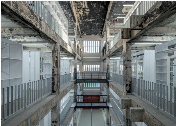
pic_04 Mit weitestgehend offenen Grundrissen auf allen Ebenen und zwei Lufträumen bis unter das Dach bot das Gebäude ideale Voraussetzungen für die Nutzung als Depot mit Werkstätten und Ausstellung.
