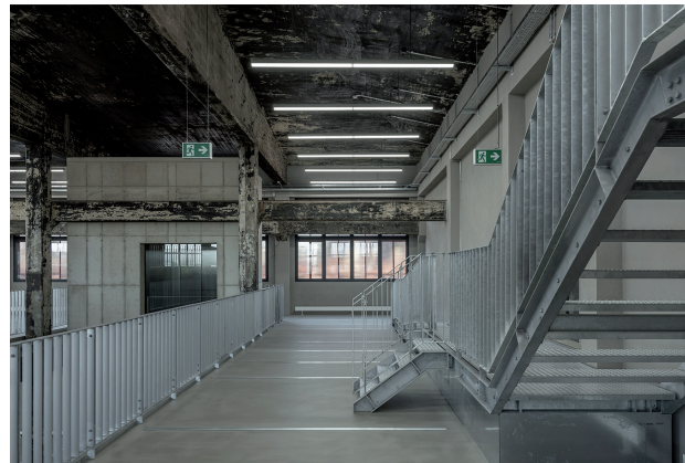
pic_05 Die bauzeitlichen Fensteranlagen aus Gusseisen-Sprossenwerk an der Nordfassade wurden denkmalgerecht saniert und zur energetischen Verbesserung um neue Innenvorfenster ergänzt.
