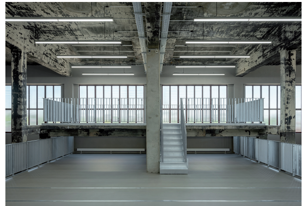
pic_07 Zur Rekonstruktion der bauzeitlichen Befensterung wählten die Architekten das thermisch getrennte Stahlprofilsystem Janisol Primo.
