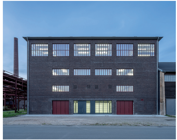
pic_03 Sie wurde als viergeschossiger Stahlbetonbau mit Flachdach und Klinkerfassade errichtet.
