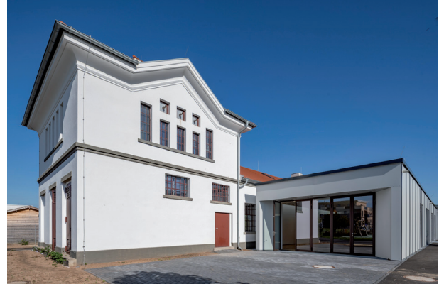
DSC_7570.jpg: An der Südseite erhielt das Werkstattgebäude einen modernen Anbau, mit Pfosten-Riegelfassaden Jansen VISS und zweiflügeligen Eingangstüren aus Janisol.
