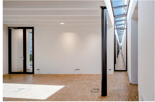
DSC_7534.jpg: Eine verglaste Fuge trennt Alt- und Neubau; sie wurde aus dem wärmedämmenden Stahlsystem VISS Dach als Schrägverglasung gefertigt. Links im Bild: F30-Brandschutztüre.
