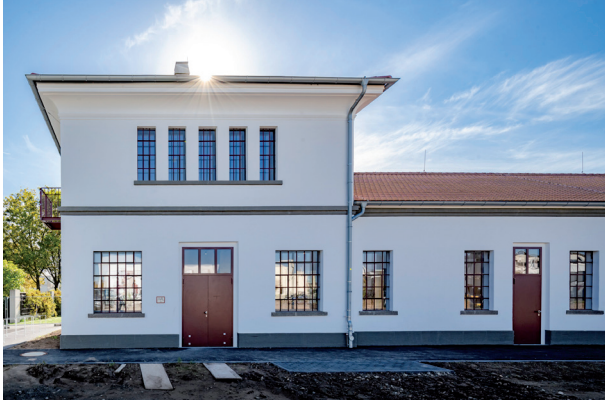
DSC_7639.jpg: In Sinn des Denkmalschutz wurden die originalen Industrieverglasungen aus einfach verglasten T-Profilen nach Möglichkeit aufgearbeitet und beibehalten.
