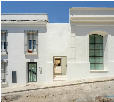
Bild 1 – Die grossen Bogenfenster zur Strasse wurden mit dem Profilsystem Jansen Art'15 realisiert. (jansen.com)
