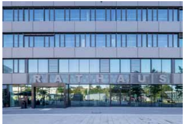
pic_06: Die Fassaden der Obergeschosse des Rathauses wurden als elementierte Aluminium-Fensterelemente (Schüco AWS 75.SI) realisiert.
