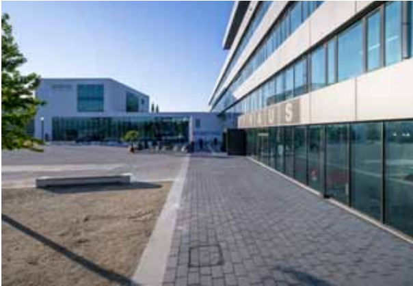
pic_03: Der Baukörper des Rathauses liegt auf dem der Stadthalle auf. In weiten Teilen verglaste Fassaden unterstreichen den öffentlichen Charakter des Ensembles.
