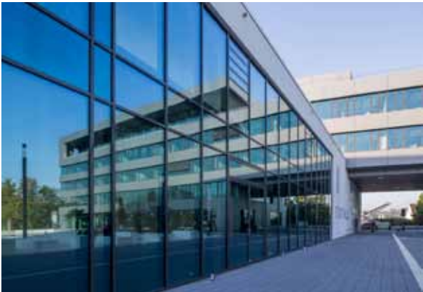
pic_05: Grossformatige Stahlfassaden (Jansen VISS 50) charakterisieren die öffentlich zugänglichen Bereiche wie Stadthalle und Rathausfoyer.
