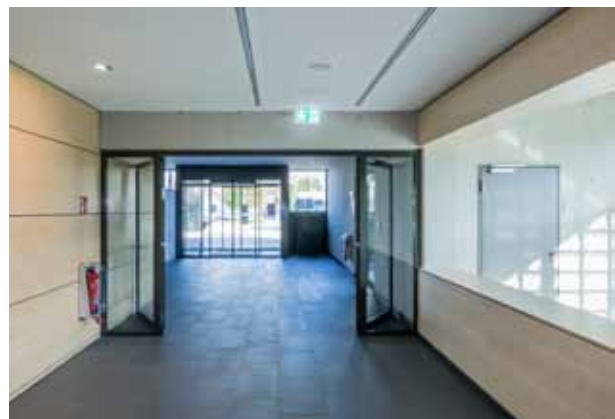
pic_08: Brand- und Rauchschutztüren bzw. -festverglasungen in den Durchgängen führen die von den Architekten angestrebte Transparenz im Inneren fort (Stahlsystem je nach Anforderung).
