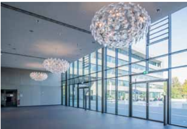
pic_07: Ausschlaggebend für die Wahl der VISS 50 Fassade war der Wunsch der Architekten nach einer filigranen Konstruktion der bis zu sieben Meter hohen Fassaden.
