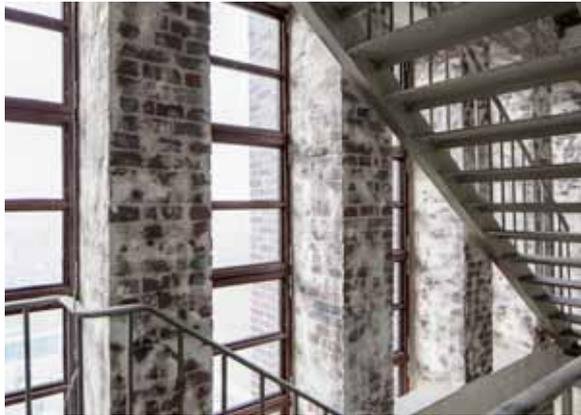
pic\_05: Bütthe & de Wall GmbH, Schortens, fertigte aus dem thermisch getrennten Stahlprofilssystem insgesamt 85 Drehflügel mit glasteilender Sprosse.
