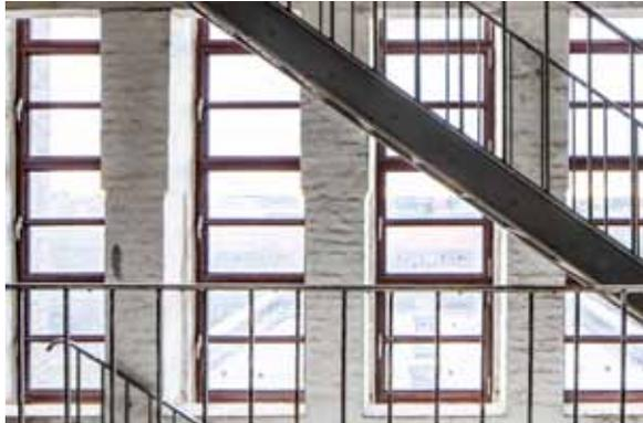
pic\_04: Für die Rekonstruktion der originalen Befensterung wählten GG/A Oda und Hannes Griesemann Architekten das Stahlfenstersystem Janisol Arte 2.0.
