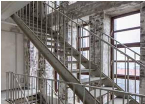
pic\_06: Jeweils zwei Drehflügel bilden ein Element. Deren vertikale Addition ergibt die Fensterbänder, die an der Fassade vor den Geschossdecken durchlaufen.
