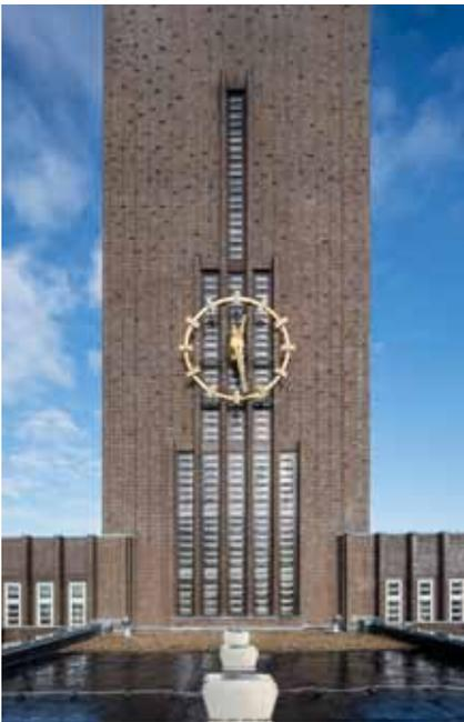
pic\_03: Bis in die 1990er-Jahre hinein sicherte der Tank im Turm den Versorgungsdruck im städtischen Trinkwassernetz.
