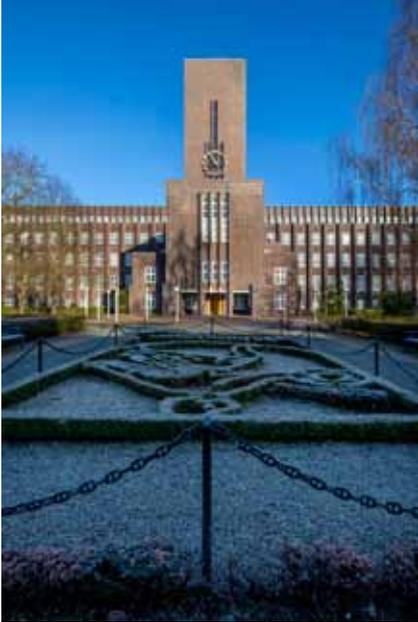
pic\_02: Aus der Mitte des etwa Hundert Meter langen Rathausgebäudes erhebt sich der ca. 40 Meter hohe Turm, der einen Wassertank beherbergt.
