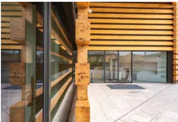
pic_06_omm3.jpg: Die 39 mm starken, bis zu 1600 x 3100 mm grossen Scheiben werden von vergleichsweise schmalen Profilen gehalten: Jansen VISS kam in nur 50 mm Ansichtsbreite zum Einsatz.
