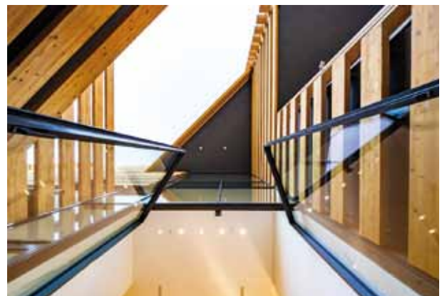
pic_07_omm60.jpg: Die überhohe VISS-Fassadenwendetüre des Eingangs ist 4415 mm hoch; die beiden Flügel sind jeweils 2140 mm breit und haben doch nur eine Stulpbreite von 140 mm.
