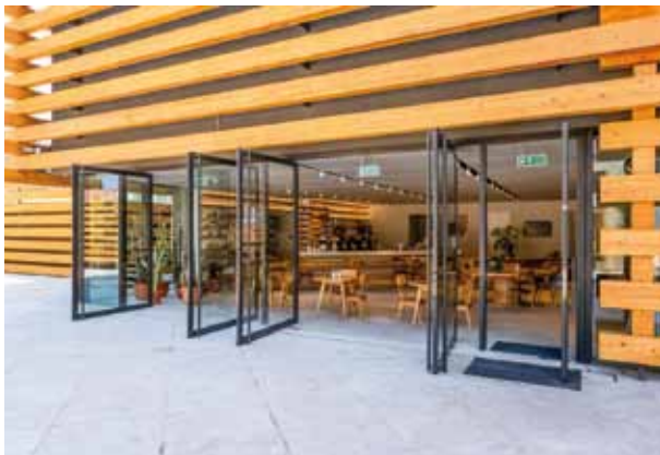
pic_04_omm37.jpg: Für die Realisierung der grossformatigen Glasfassaden in den Eingangsbereichen sowie der Fassaden zu den Terrassen wählten die Architekten das Stahlprofilssystem VISS.
