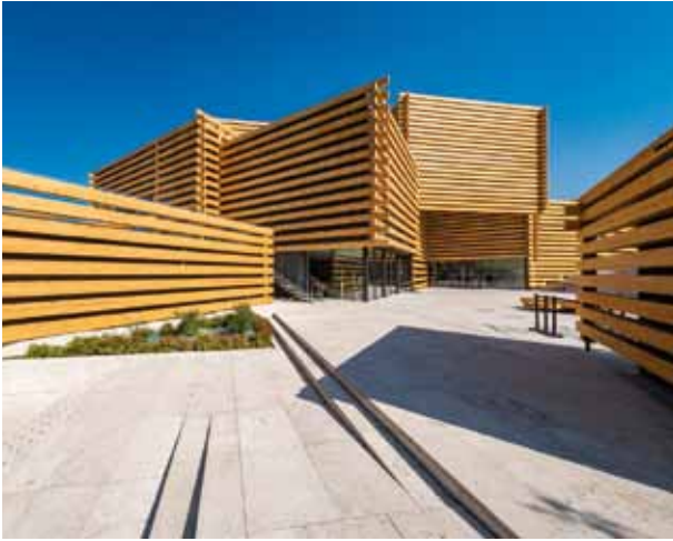
pic_02_omm69.jpg: Die Topografie des Geländes führte zur Ausbildung von zwei Eingängen: Der Hauptzugang mit Foyer und Empfang befindet sich in der untersten Ebene (siehe pic_01).
