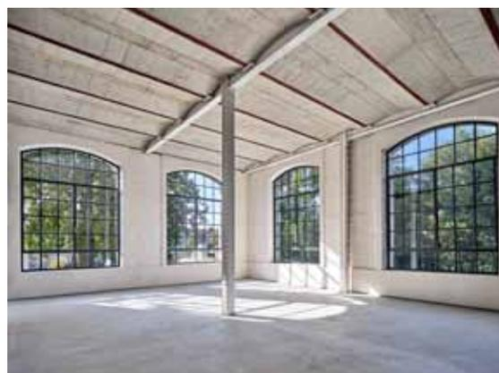
pic\_06: Für alle anderen Bereiche wurde ein Verbundfenster mit Glasteilung zwischen der äusseren und der mittleren Isolierglasscheibe der dreifach verglasten Konstruktion entwickelt.
