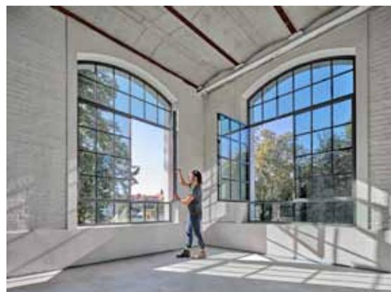
pic\_08: Seine Bautiefe von 66 mm (daher der Name Janisol Arte 66) erlaubt den Einbau stärkerer Gläser, und das bis zu einer Flügelhöhe von 2300 mm.
