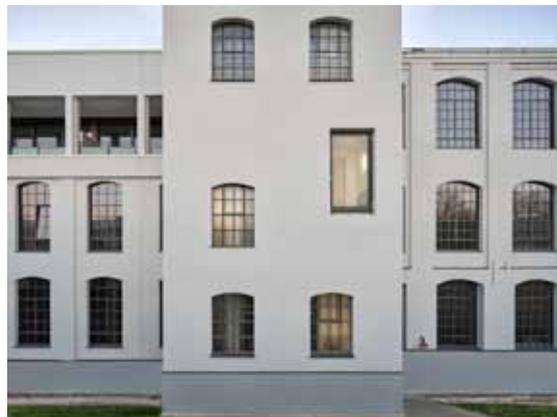
pic\_04: Linker Hand des Treppenhauses die vergleichsweise kleinen Verglasungen des Baus von 1900, rechter Hand die des Baus von 1908. Oben links die Neubauwohnungen.
