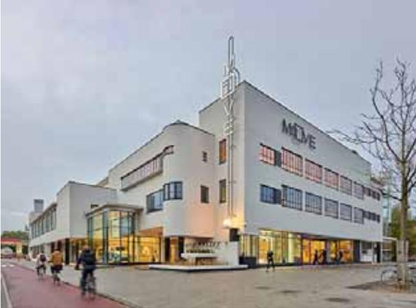
pic\_01 CF011580C: Anlässlich der Sanierung wurden die originalen Fensteröffnungen wieder hergestellt und mit feinen Sprossenfenstern aus dem Stahlsystem Janisol Arte 2.0 geschlossen.
