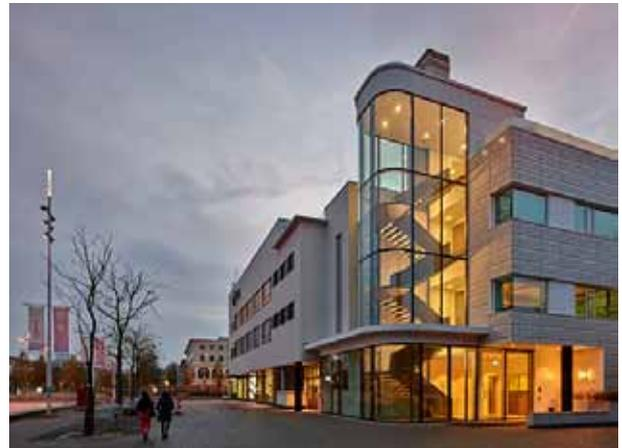
pic\_02 CF011566C: Die Schnittstelle zwischen Alt- und Neubau markiert ein neuer Eingang mit einem rundum verglasten Treppenhaus aus im Grundriss gebogenen Stahlprofilen VISS SG.
