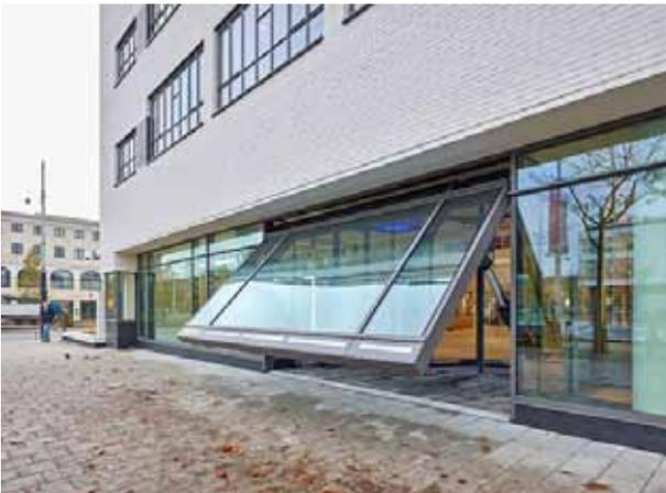
pic\_01 CF011635: Ein Element der dem Stadionsplein zugewandten VISS Fassade kann mit einem Hydrauliksystem um 90 Grad nach oben geschwenkt werden.
