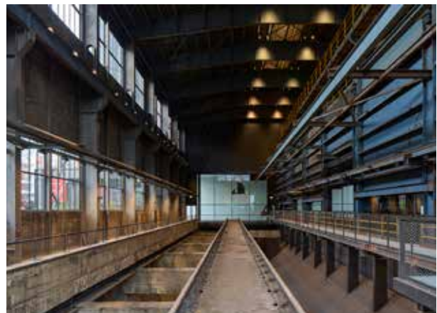
230926_0172.jpg: Fensterbänder aus Jansen-Economy; zur Bibliothek hin: thermischer Abschluss aus VISS TVS.
