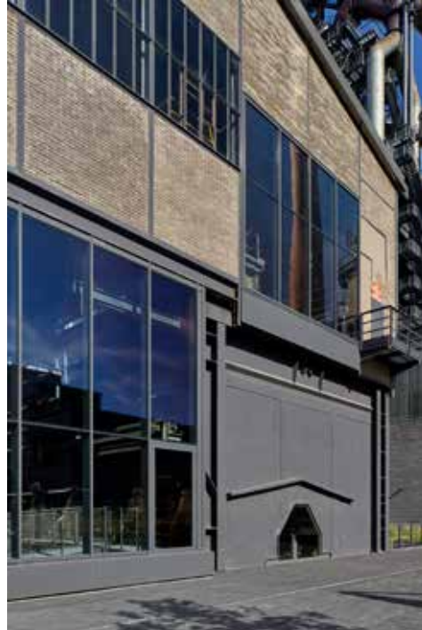
230926_0067.jpg: Glasfassaden VISS TVS; rechts daneben voll verblechte Janisol Türe
