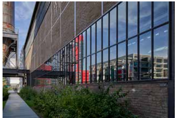
230926_0084hdr.jpg: Fensterbänder aus Jansen-Economy 50 bewahren die bauzeitliche Ansicht der Längsfassaden.
