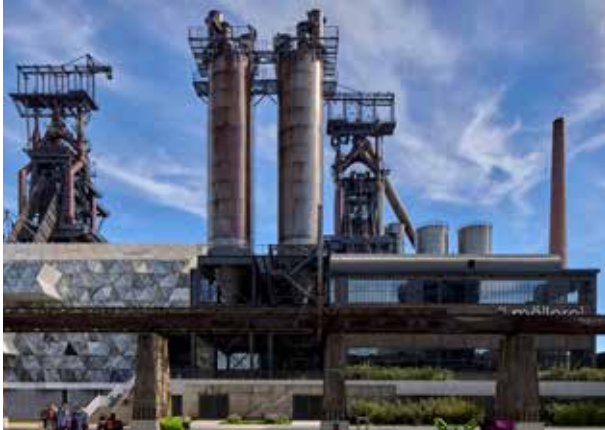
230926_0008.jpg: Übergang von der Universitätsbibliothek (links) zur Veranstaltungs- und Ausstellungshalle (rechts).
