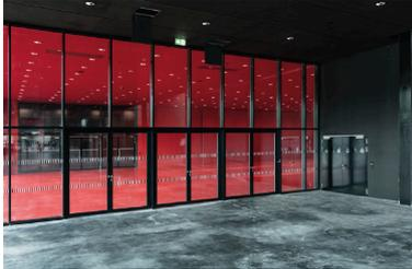
**Bild 4:** Bei den stark frequentierten Erschließungsbereichen garantieren die Brandschutztüren Janisol C4 EI60 hohe Stabilität und sicheren Brandschutz.
