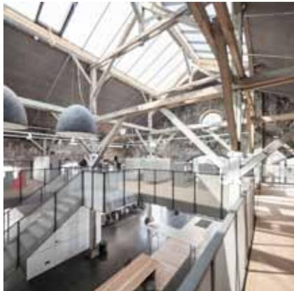
pic\_02: Das Oberlicht im Firstbereich wurde durch eine wärmegeämmte Konstruktion aus dem Stahlprofilssystem Jansen VISS ersetzt.
