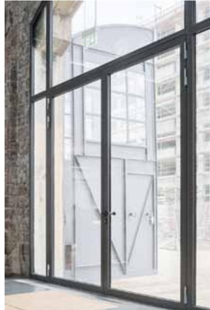
pic\_04: Den gegebenen Tor- und Fensteröffnungen wurde jeweils eine Konstruktion aus dem thermisch getrennten Stahlprofilssystem Janisol (Tore) bzw. Janisol Primo (Fenster, s.u.) vorgesetzt.
