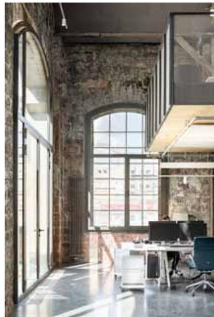
pic\_05: Mit der Entscheidung, diese nicht in die Laibung, sondern vor die Innenwand zu setzen, ersparte man sich den erfahrungsgemäss schwierigen Anschluss an den Altbau.
