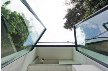
**Bild 2:** Zwei riesige Flügel mit je 3 m Breite und 6 m Höhe bilden die gläserne, öffentbare Rückseite des Altstadthauses. Eine Kombination von Profilergänzungen verstärkt die verwendeten Jansen Profile vom Typ VISS Fassade.
