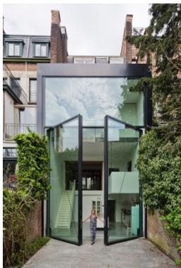
**Bild 1:** Gartenseitig wurde der Bau oberhalb des gewachsenen Terrains in der Höhe von drei Etagen mit größtmöglicher Geste und radikaler Konsequenz geöffnet und erweitert. Statt einzelner Fenster wurde eine riesige Wendetüre eingesetzt.
