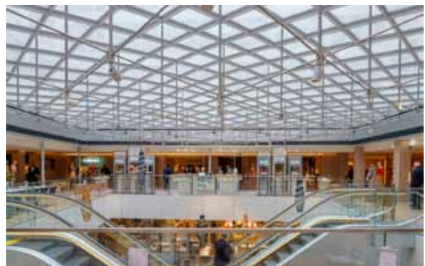
pic_05: Für den „Dôme“ im Jourdain-Bau, ein gewölbtes Glasdach von ca. 18 x 20 m, wurden Jansen VISS und Jansen VISS Fire unauffällig kombiniert.
