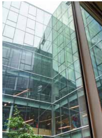
pic_07: Die Pfosten-Riegelfassade Janisol 2 wurde trotz Brandschutzanforderung in SG-Optik und mit integrierten Senkklappfenstern gefertigt.
