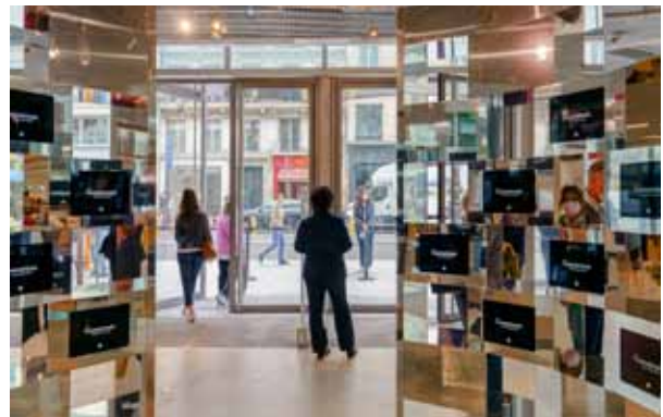
pic_03: Die 3,30 m hohen Flügel der Brandschutz-Pendeltüren des Haupteingangs wurden aus dem Stahlprofilsystems Janisol 2 EI 30 gefertigt.
