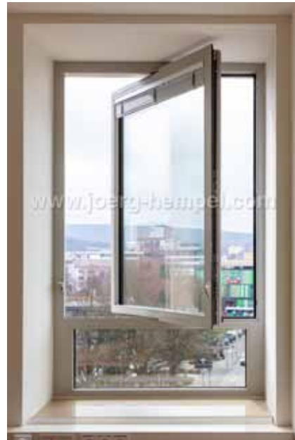
pic_016: Die Seilführung des motorisch betriebenen Mikrobehangs ist in der Glasleiste integriert. Die Stromzufuhr erfolgt über das eigens hierfür entwickelte Drehlager, welches mittig einen Durchlass für die Verkabelung hat.
