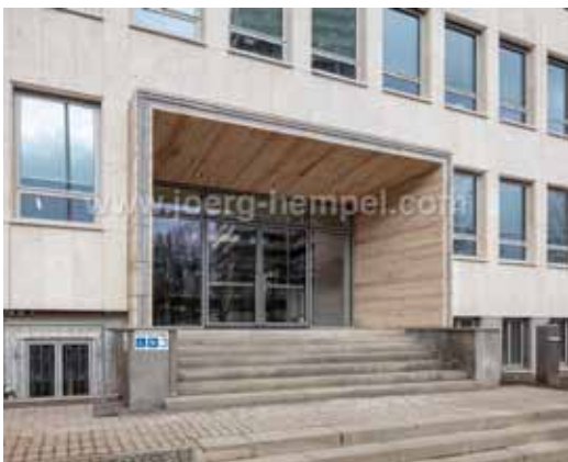
pic_015: Auch die zweiflügelige Vollpaniktüre mit fest stehenden Seitenflügeln und Oberlicht wurde mit dem Stahlprofilssystem Janisol und Applikationen aus hell beschichteten Aluleisten originalgetreu rekonstruiert.
