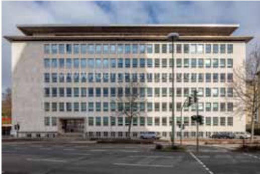
pic_003: Eine streng gegliederte Natursteinfassade und für die Bauzeit typische Wendefenster charakterisieren das Gebäude aus den 1950er-Jahren.
