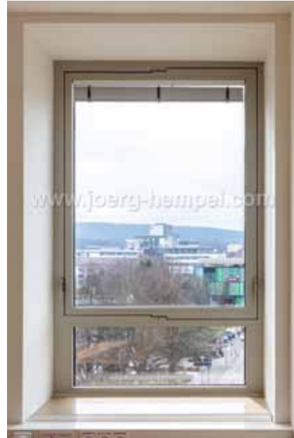
pic_017: Es war der Wunsch der Architekten, die Ansichtsbreiten soweit wie möglich zu minimieren. Erreicht wurde dies durch einen Wechsel der Ansichtsbreite des Profils im unteren und oberen Drehlager.
