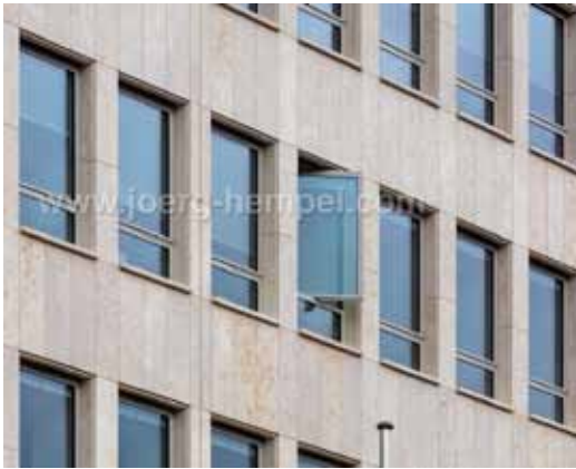
pic_010: Bei der Erneuerung der Fassade verwendeten die Architekten Muschelkalk und das Stahlprofilssystem Janisol HI, um das originale Erscheinungsbild bewahren.
