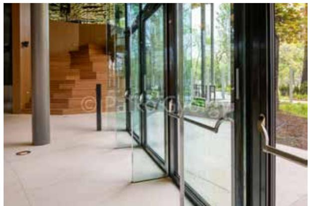
Hungarian\_House\_of\_Music-12.jpg: Das reibungslose Zusammenspiel von Türflügel, Blendrahmen und Beschlagteilen sichert die zuverlässige Funktion der Fluchttüren mit Panikverschluss.
