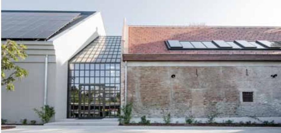
pic\_02 AC1A5557.tif: Ein Glastrakt aus dem Stahlsystem Jansen VISS 50 verbindet das sanierte mit dem neu erbauten Betriebsgebäude.
