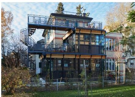
**Bild 1:** Das 1891 im Stil der Gründerzeit erbaute Wohnhaus erhielt einen industriell wirkenden, gläsernen Anbau aus rohen Stahlträgern und Janisol Arte 2.0 Stahlprofilen.
