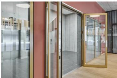
**Bild 6 und 7:** Das Pergamin II besitzt zwei Treppenhäuser inklusive Lifte. In jedem Stockwerk bis auf das Untergeschoss ist dieser Erschliessungsbereich durch die Festverglasungen mit Janisol 2 EI30 und doppelflügelige Glastüren Janisol C4 zu den Stockwerken hin geöffnet.
