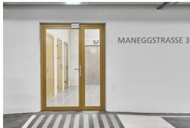
**Bild 4 und 5:** Auch im Untergeschoss unterstreichen Janisol 2 EI30 Profile in Verbindung mit der wärmegeämmten Brandschutztür Janisol C4 das Energiekonzept wie auch den Brandschutz.
