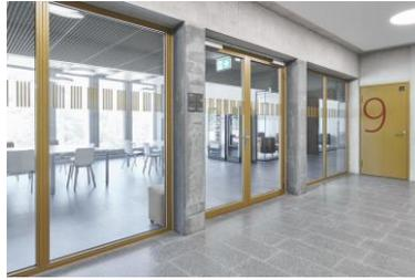
**Bild 2 und 3:** Mit Janisol 2 EI30 konnten multifunktionale transparente Innenabschlüsse und Trennwände mit modernen, filigranen Profilen realisiert werden. Sie entsprechen dabei vollumfänglich dem Brandschutz eines hochfrequentierten Bürogebäudes.
