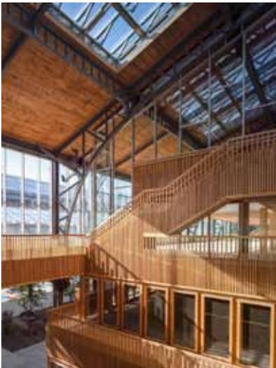
pic\_05: Da die historische Konstruktion nicht belastet werden durfte, ruhen die VISS Fassaden auf den Deckenbalken des 2. OG.
