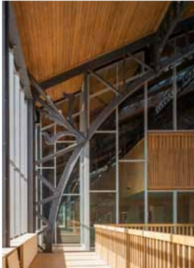
pic\_06: Im 3. OG sind die VISS Fassaden an der Geschosdecke befestigt und darüber hinaus mit Druckstäben an zwei weiteren Punkten fixiert.
