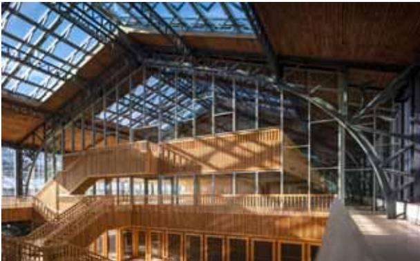
pic\_03: Die grossflächigen Glasfassaden an den Giebelseiten der Pavillons wurden ab dem 2. OG als frei tragende Stahlleichtbaukonstruktion errichtet.
