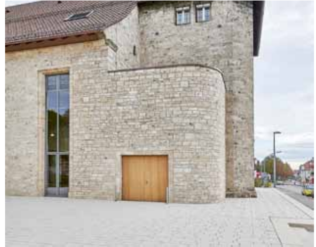
pic_04 Johanneskirche: Lamellenfenster dienen der Lüftung sowie dem Rauchabzug; das mittlere Feld ist fest verglast und im EG gibt es Drehtüren.
