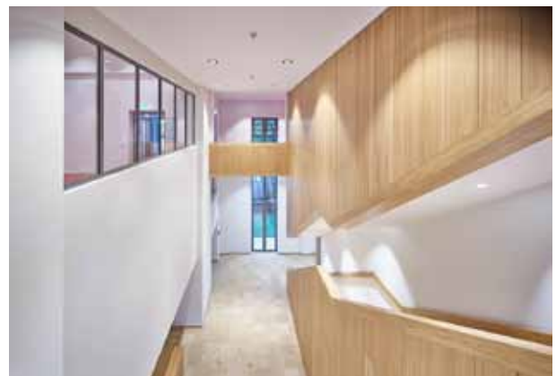
pic_08 Johanneskirche: Eine Brandschutzverglasung aus Janisol 2 schliesst den Jugendraum zum Treppenhaus hin ab.
