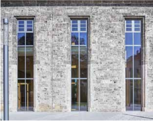
pic_03 Johanneskirche: Die ursprünglich 2,50 m hohen Fenster wurden bodentief geöffnet und messen nun fast 8 m.
