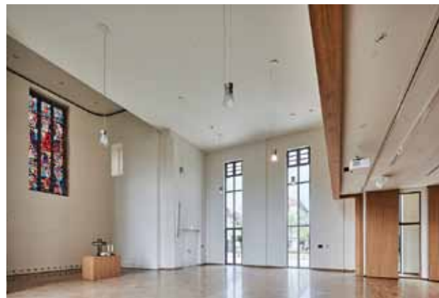
pic_06 Johanneskirche: Die bodentiefen Verglasungen mit Drehtüren im unteren Bereich fungieren auch als Fluchtweg.
