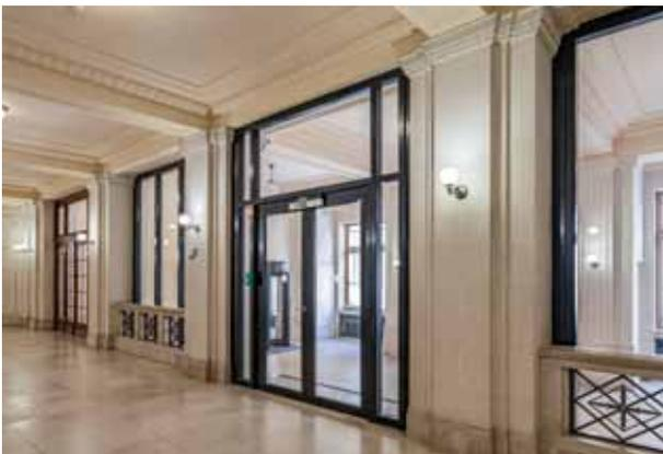
pic\_23: Zu den objektspezifischen Sicherheits- und Schutzvorgaben zählen auch eine Reihe von ein- und zweiflügeligen Drehtüren auf der Basis des Stahlprofilsystems Economy 60 von Jansen.
