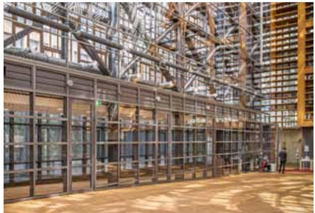
pic\_02: Die Aufeinanderfolge verglasteter Schichten mit unterschiedlichen Sicherheitsstandards gewährleistet einen der jeweiligen baulichen Situation „angemessenen“ Widerstand.
