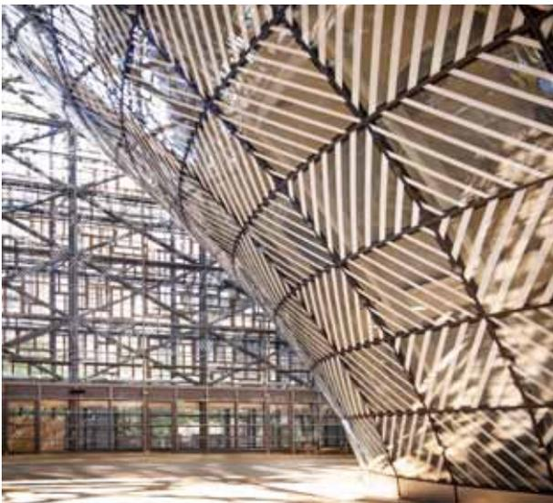
pic\_05: So sind die schussicheren Dreifach-Verbundgläser der thermischen Fassade im besonders gefährdeten Eingangsbereich zusätzlich verstärkt.
