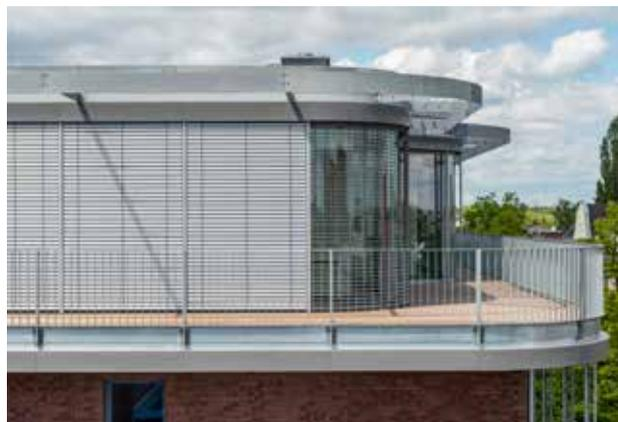
An der gesamten Fassade wurde ein aussen liegender Sonnenschutz realisiert; an den Rundungen als gebogen gelaserte Sonderanfertigung.
