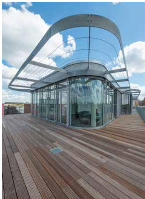
Mit gebogenem Glas an den Gebäudeecken entstand eine fließende Verbindung zu den geradlinigen Fassaden des Bestandsgebäudes.
