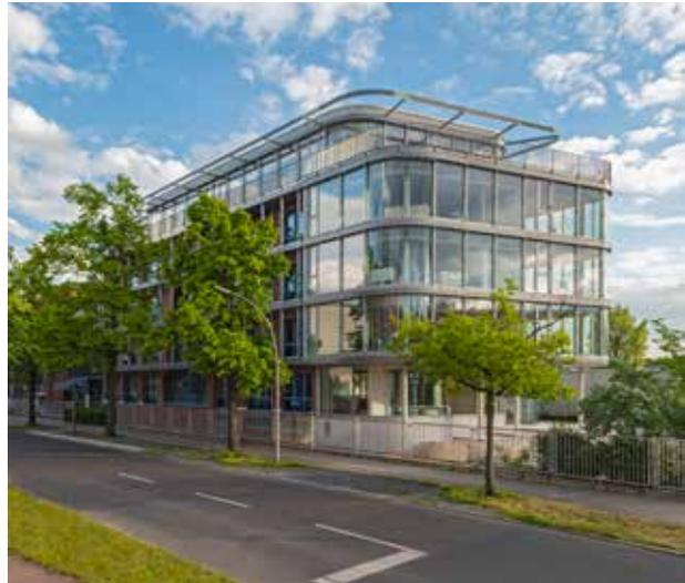
Metallbau Windeck fertigte die raumhohen Pfosten-Riegelfassaden aus dem Stahlsystem VISS Fassade.
