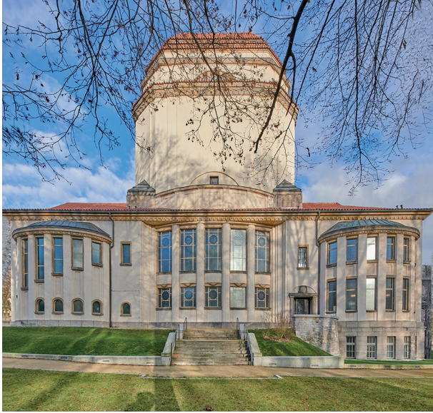
Am Gebäude findet sich eine Vielzahl von Fensterformaten und Öffnungsarten.
