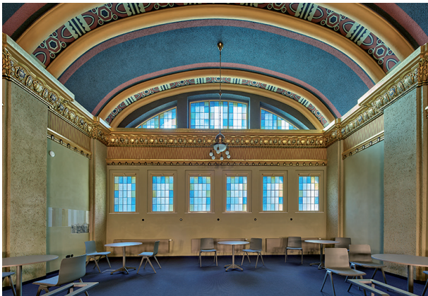
Auf der (zum Gebetsraum hin offenen) Frauenempore wurden die Fenster mit buntverglasten Scheiben erneuert.
