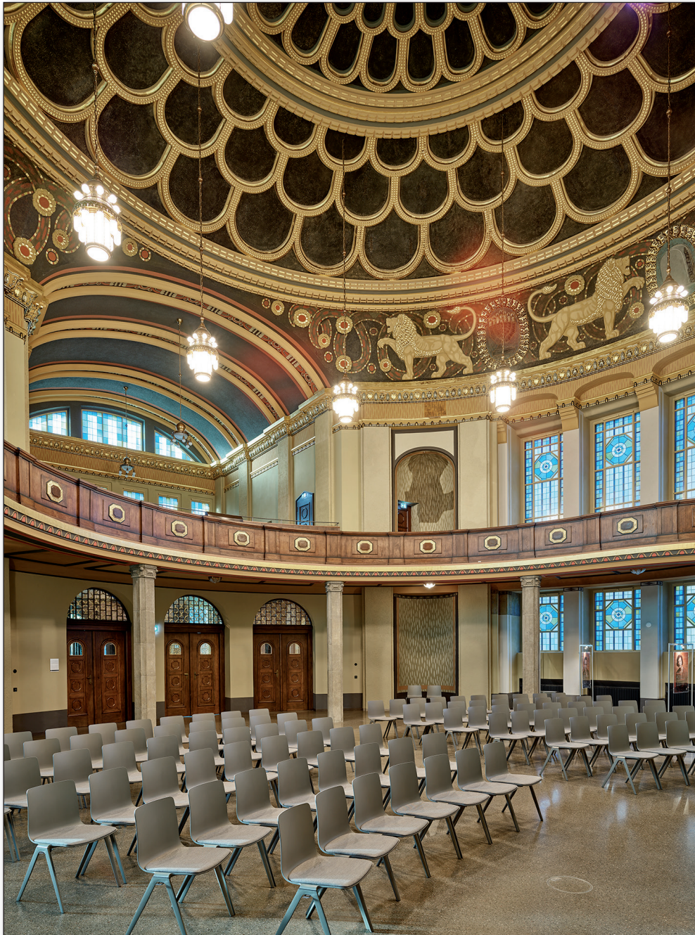
Mit ihrer flachen Stahlbetonkuppel (und der Stahlskelettkonstruktion des mächtigen Turmes, siehe Folge- seite) zählt die zwischen 1909 und 1911 errichtete Synagoge Görlitz zu den ersten Monumentalbauten, die die ingenieurtechnischen Möglichkeiten des noch jungen Stahlskelettbbaus ausreizten. Denkmal- pflegerisches Ziel der Sanierung war es, maximal viel Bausubstanz zu erhalten oder originalgetreu zu rekonstruieren.
