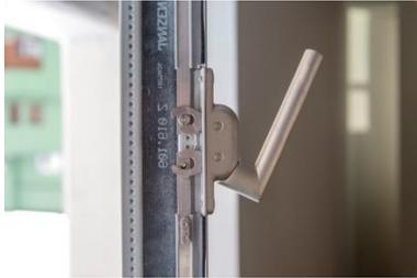
Bild 7: Die Beschläge der Fenster stammen auch aus dem System Janisol Arte und wurden teilweise speziell als Vertikallösung eingebracht.
