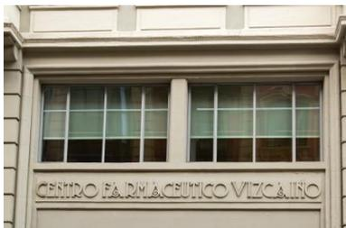
Bild 4: Die ursprünglichen Sprossenfenster konnten mithilfe von Janisol Arte mit schmalere Ansichtsbreiten ersetzt werden, was zu einem höheren Glasanteil und damit zu mehr Lichteinfall führte.
