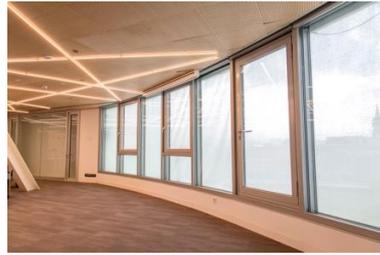
Bilder 5+6: Im ergänzten Dachgeschoss wurden ebenfalls Stahlprofile Janisol Arte 1.0 eingesetzt.
