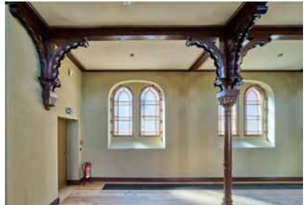
pic_04: Die schlichten, bleiverglasten Fenster von 1880 wurden vollständig restauriert und sicherheits-technisch ertüchtigt.
