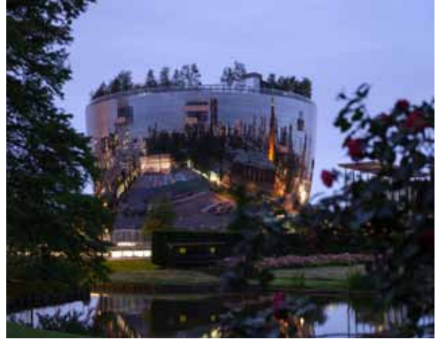
pic_03_075_Depot_2020©OvD.jpg: Der nach oben wachsende Umfang des Gebäudes, von 40 m Durchmesser im EG auf 60 m oben, minimiert die Versiegelung des Grundstücks.
