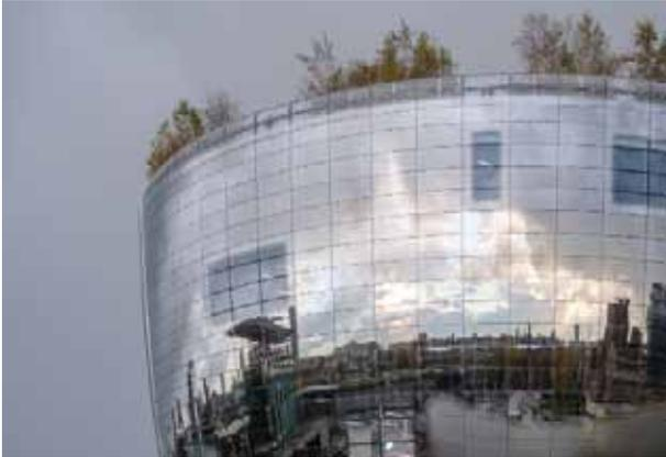
pic\_02: 310\_Depot\_november: Die Befestigung der zweifach, teils dreifach gewölbten Paneele mittels speziell berechneter Anker erforderte umfangreiches Engineering vonseiten aller Beteiligten.
