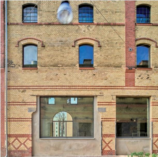
pic\_06\_7881: EG: Festverglasung aus Janisol HI mit Durchblick auf die Brandschutz-Festverglasung Janisol 2. Im 1. OG: Wechsel von Festverglasungen und Schwingflügeln aus Janisol Arte. Im 2. OG: aussen Bestandsfenster, innen Drehflügel aus Janisol Arte 2.0.
