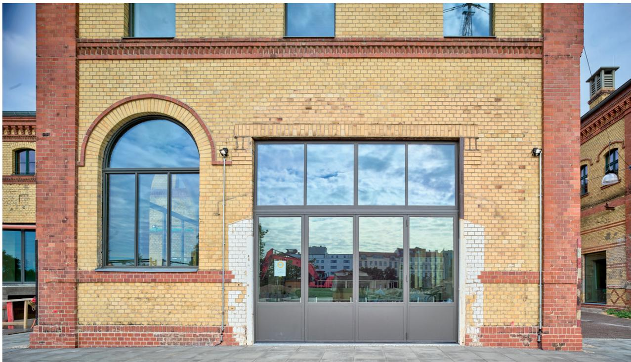
pic\_08\_7848 (oben): Rundfenster Janisol Arte 2.0 mit aufgesetztem Applikationsrahmen und Janisol-Falttoranlage. Die Besonderheit der Falttoranlage: Ihr Gewicht wurde am Oberlicht abgelastet!
