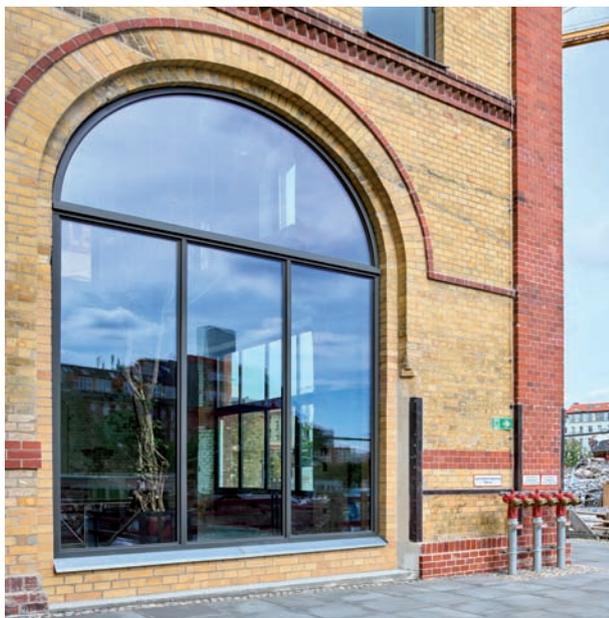
pic\_09\_8218: Brandschutz-Festverglasung Janisol 2 mit von außen unsichtbar verschraubtem Applikationsrahmen.
