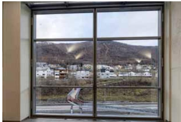
pic\_04: Mit dem hoch belastbaren Stahlsystem konnte die 4,80 m breite Öffnung mit einer 2flg. Konstruktion geschlossen werden.
