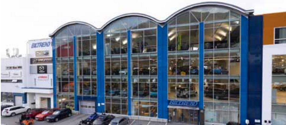
pic\_01: Die Glasfassade des viergeschossigen Neubaus wurde durchwegs mit einem Aluminium-Profil im Raster von 4,80 Meter gefertigt, wobei jeweils drei 1,60 Meter breite Glasscheiben ein Feld füllen.
