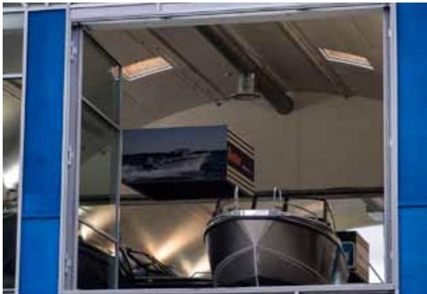
pic\_03: Lediglich das Feld, das öffnen gehalten werden sollte, wurde mit dem Stahlsystem Jansen VISS verglast.
