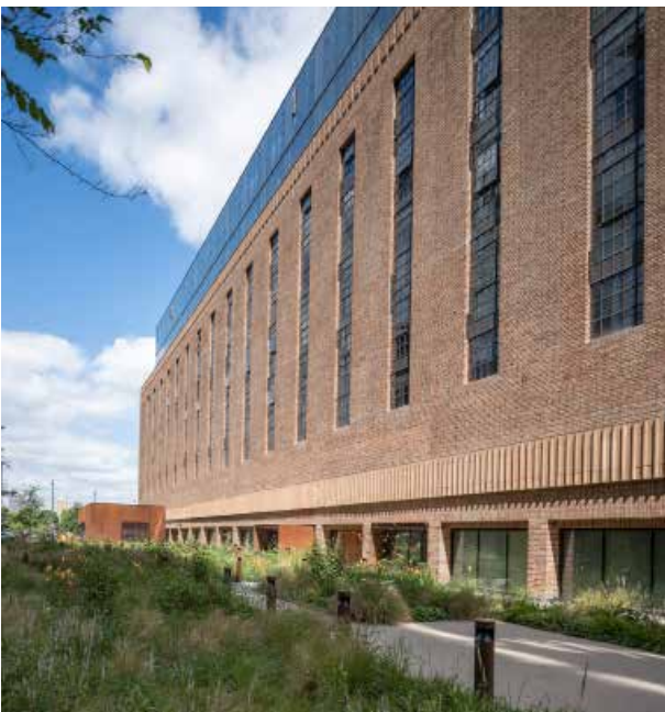
47_BPS © Tim Fisher: Grossflächige Industrieverglasungen aus thermisch getrennten Stahlssystemen von Jansen erhöhen den Lichteinfall und sichern zeitgemässe energetische Standards.
