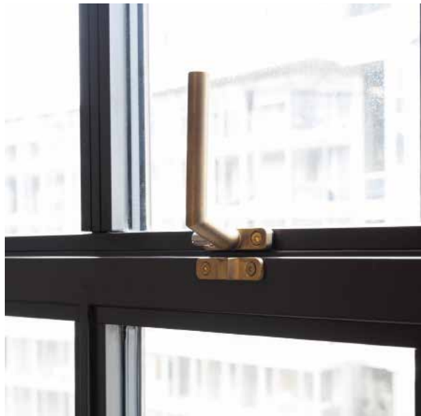
13_BPS © Tim Fisher: Zum Öffnen wird der Griff um 90 Grad nach oben gedreht und das Senkklappfenster nach aussen aufgestellt.
