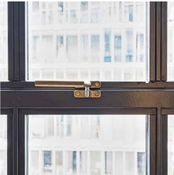
11_BPS © Tim Fisher: Die geradlinigen Bedienelemente in Messingoptik wurden eigens für das Projekt von Jansen entwickelt.
