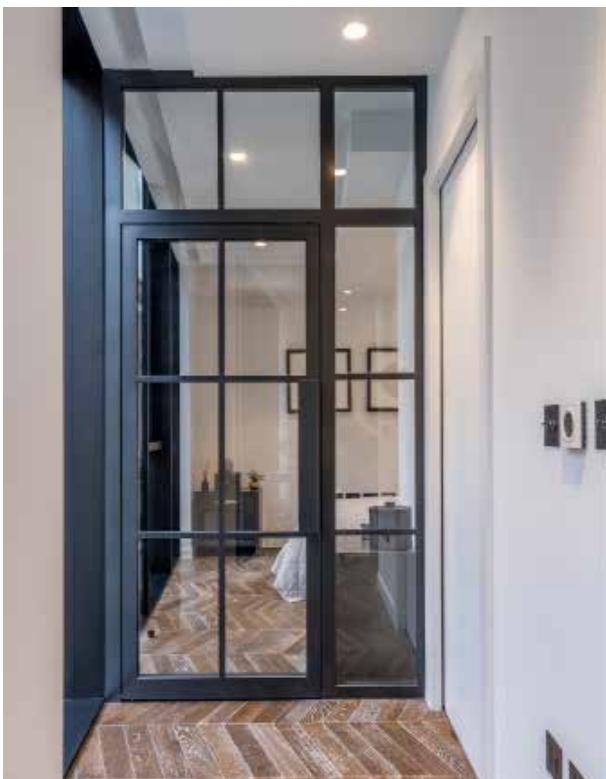
22_BPS © Tim Fisher: Raumteiler und Innentüren aus Stahlprofilen harmonisieren mit den Industrieverglasungen aus Janisol Arte 2.0 an den Fassaden.
