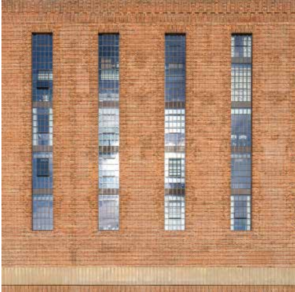
35_BPS © Tim Fisher: Um den Lichteinfall im Inneren des Gebäudes zu erhöhen, wurden vorhandene Öffnungen vergrößert und ausfachendes Mauerwerk durch Glaskonstruktionen ersetzt.
