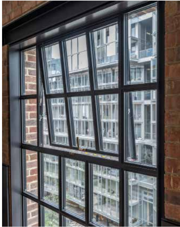
10_BPS © Tim Fisher: Mit nur einem Handgriff kann das 1 m x 1 m grosse Senkklappfenster nach aussen aufgestellt werden. Die 1,10 m x 1,45 m grossen Elemente werden mit zwei Griffen bedient.
