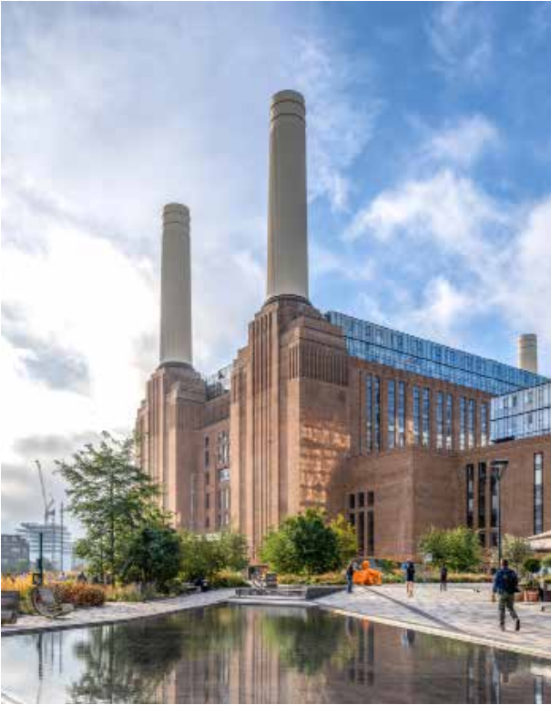
01_BPS © Tim Fisher: Die legendäre Battersea Power Station wurde nach dem Entwurf des Londoner Büros Büro WilkinsonEyre. Architects in ein gemischt genutztes Gebäude umgewandelt.
