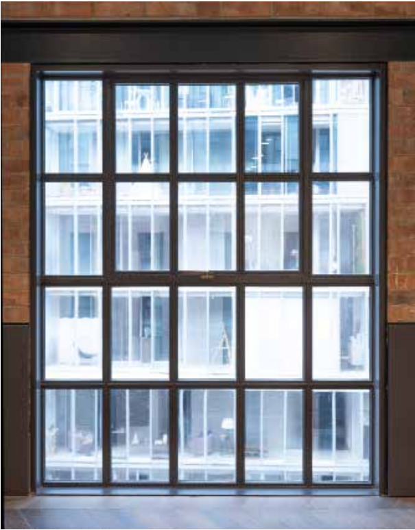
14_BPS © Tim Fisher: Mit seiner grossen Vielfalt an Öffnungsarten – hier: Senkklappfenster – eignet Janisol Arte 2.0. sich hervorragend für die Sanierung historischer Industrieglasungen.
