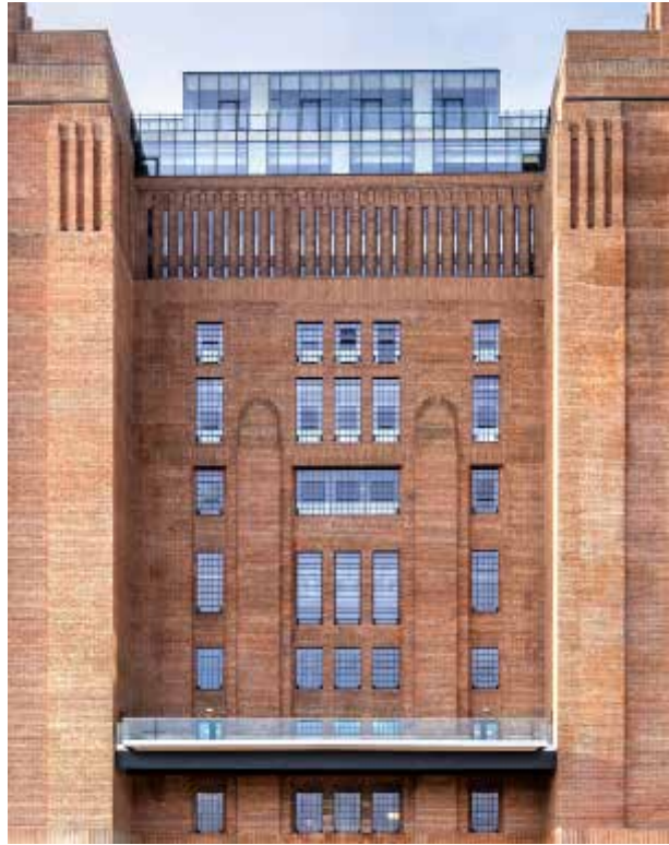
38_BPS © Tim Fisher: Die sorgfältig abgewogene Kombination erhaltender und erneuernder Massnahmen bewahrt den Charme des Industriedenkmals für künftige Generationen.
